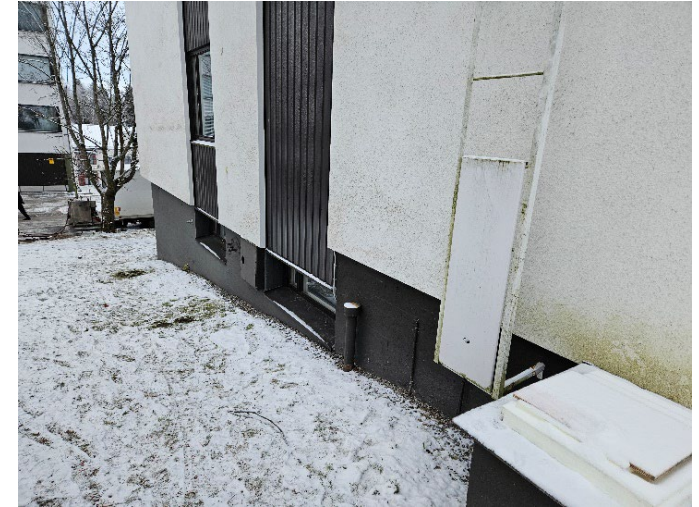
Kuva 27. Ulkoseinän lisäeristäminen kerrostaloissa. Julkisivun lisäeristetty pinta on ulompänä kuin lautaverhoitu julkisivupinta. Kuva maastokäynniltä 5.12.2024 Immo Kuha / Ramboll
