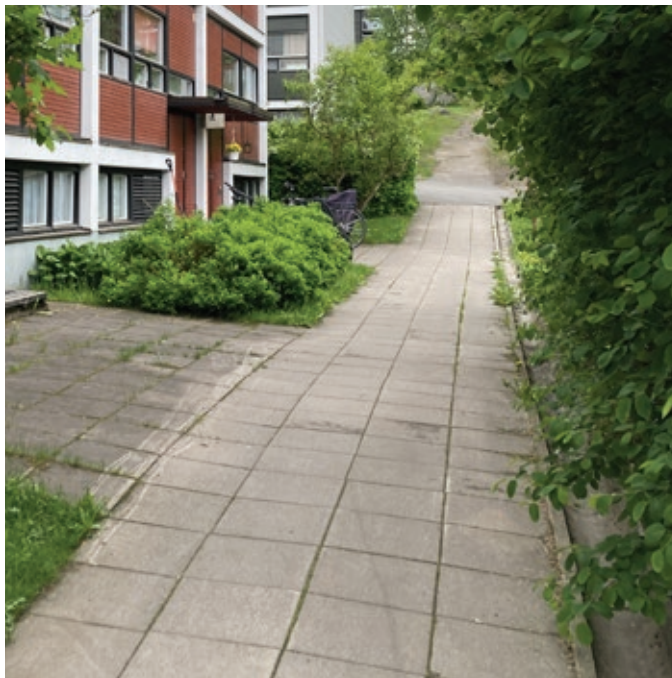
Vanha, jo patinoitunut betonilaatta (400 x 400 mm) yhdistyy suoraan istutusalueeseen. Oikealla betonikouru.
