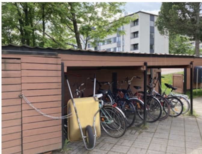
Alkuperäinen varastokatos on matalahko, ja sen korottamista voidaan harkita.
