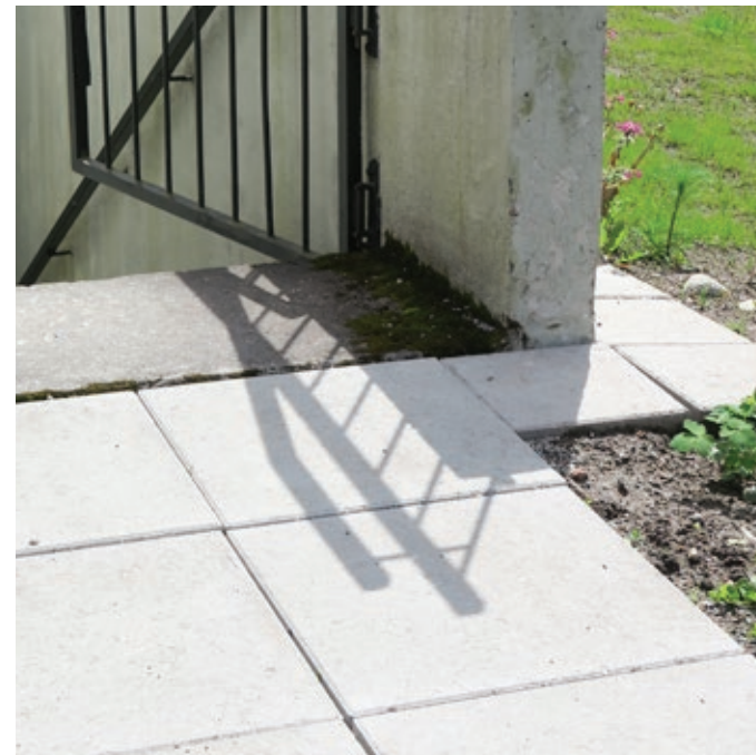
Uusittua betonilaattaa isommassa (500 x 500 mm) ja pienemmässä (300 x 300 mm) koossa. (Kuva Leena Buller 2022)
