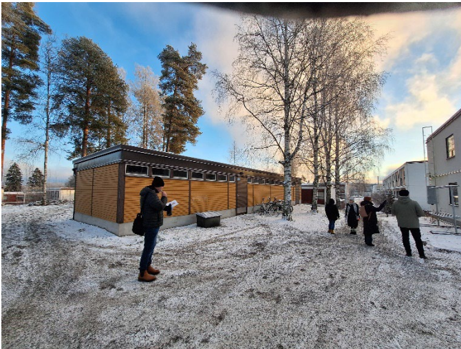
Kuva 29. Yhteistontin 13-6 ulkorakennus on alueen uusinta rakennuskantaa, toteutettu 2010-luvun puolivälissä, mutta ulkoasultaan alueen alkuperäisten tyyppi- ja materiaalien mukaisina. Kuva maastokäynniltä 5.12.2024 Kirsikka Siik / Ramboll
